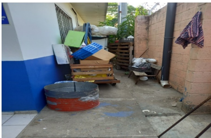
Tapial de bloque de concreto de 15x20x40 y contrafuertes lado norte.
